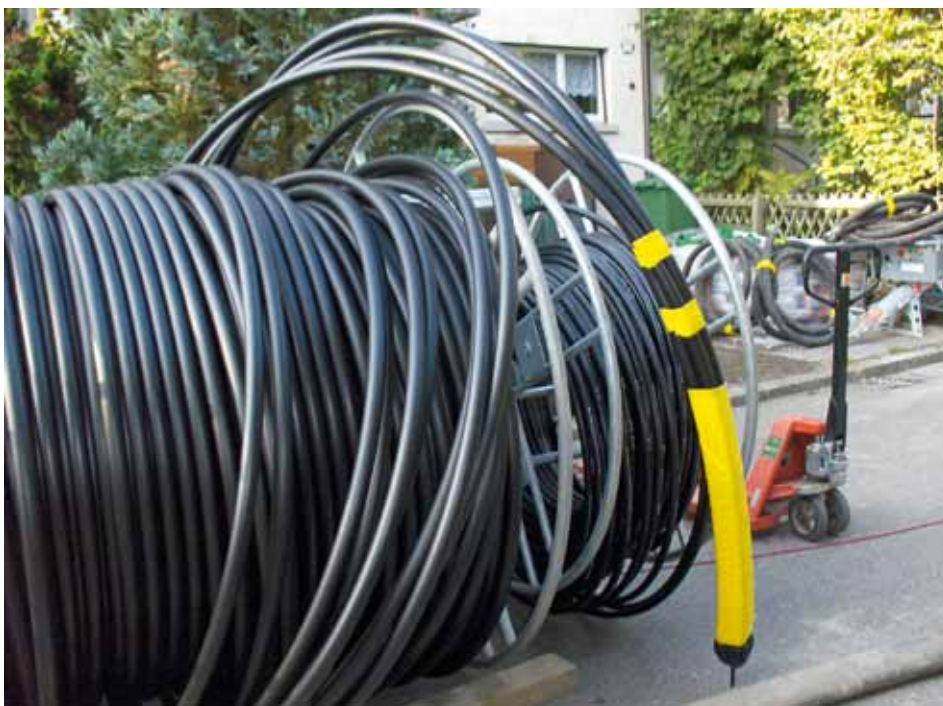
Erdwärmesonde bereit zum Einbau in ein Bohrloch.
