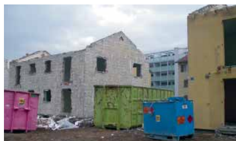
Ist Ersatzneubau die richtige Massnahme?
